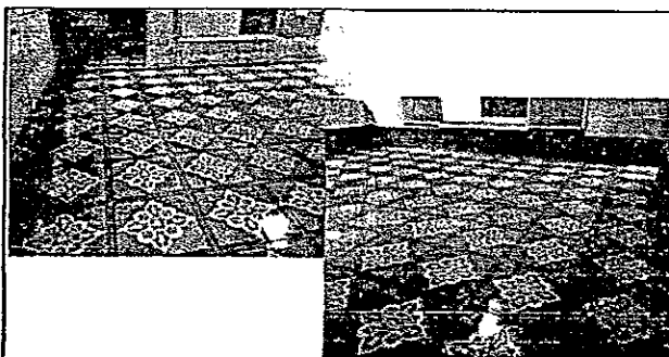
Foto 6: Acabado final de piso en aulas.
